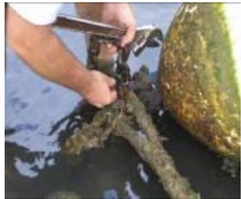
Las cadenas y, por tanto, las cordadas, se tensan mediante gomas. Para instalar las gomas, fijaremos un extremo lo más cerca posible del "muerto" y el otro a un eslabón de la cadena, dejando un seno en ésta
